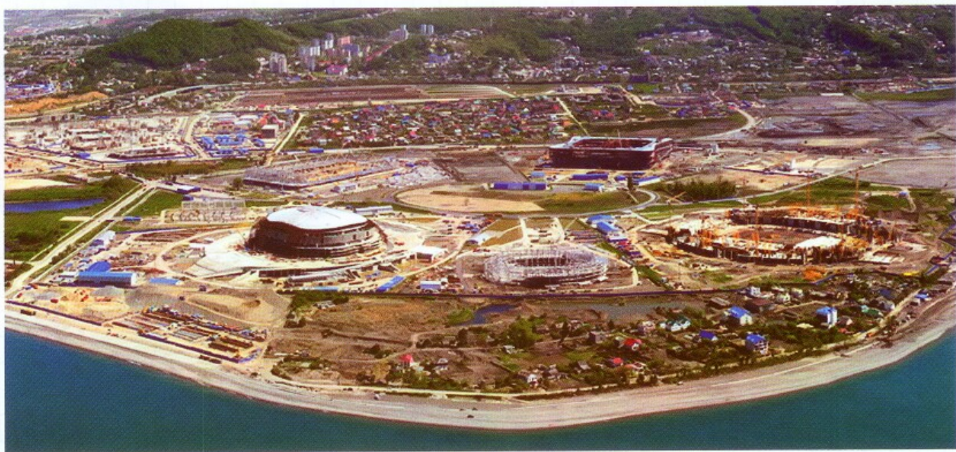
▲ Олимпийская стройка: дорогая и «зеленая»
